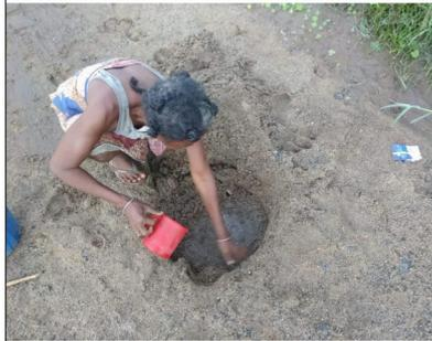
Lorsque le terrain est sablonneux la paroi du trou ne peut pas tenir car le sable retombe dans le puits. Nous proposons donc de protéger la paroi avec des buses en béton mais pas dans le lit de la rivière.
